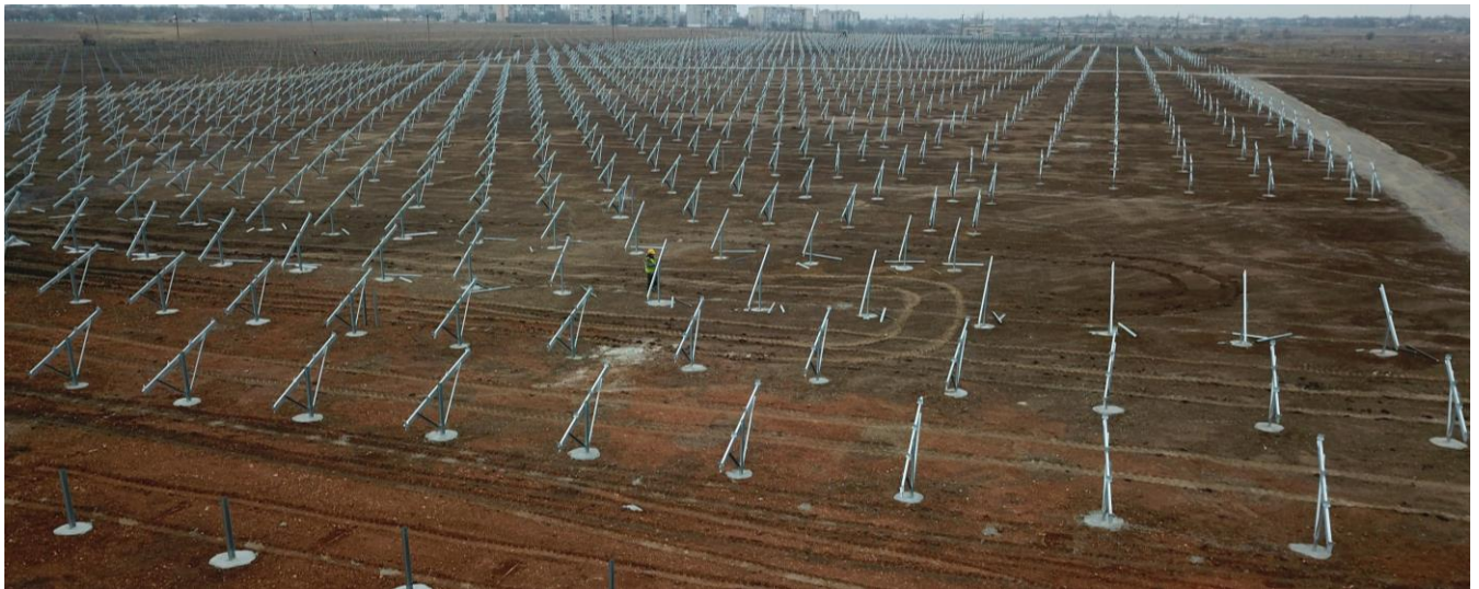
Рисунок 34 - Встановлення опорних металоконструкцій фотоелектричних панелей
