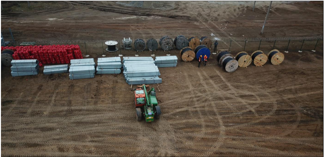
Рисунок 33 - Влаштування тимчасового складського майданчика на території СЕС
