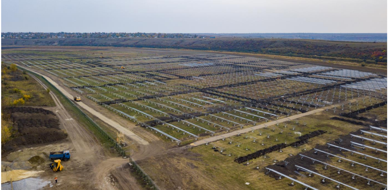
Рисунок 36- Розробка траншей по території електростанції для укладання заземлювача та установка опорних металоконструкцій фотоелектричних панелей
