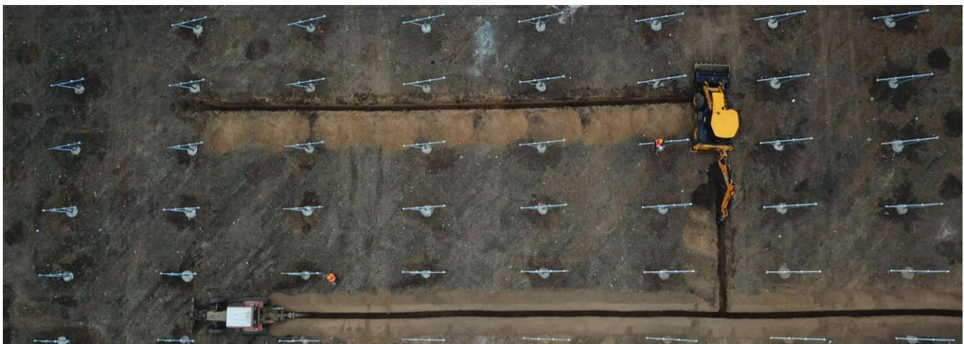
Рисунок 35 - Розробка траншей по території електростанції для укладання заземлювача
